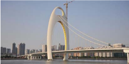
(b) Liede Bridge (2009, China)
