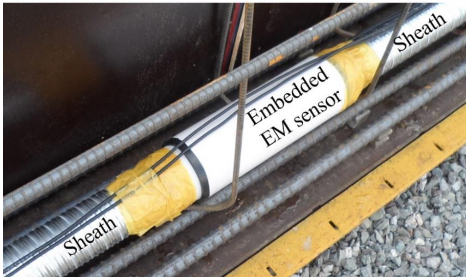
Fig.2 Installation of embedded EM sensor
